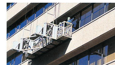
NKKビルの作業風景
